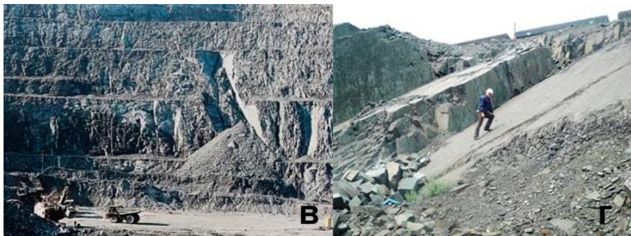
Рисунок 7 – Примеры фактических макродеформаций: а, в – клиновидные деформации; б – деформация опрокидывания, г – плоская деформация
